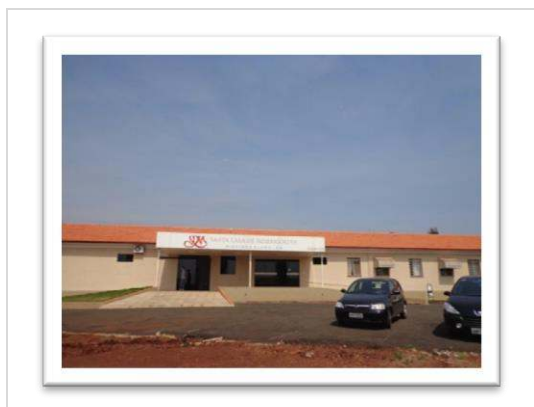
Figura 15: Santa Casa da Misericórdia
